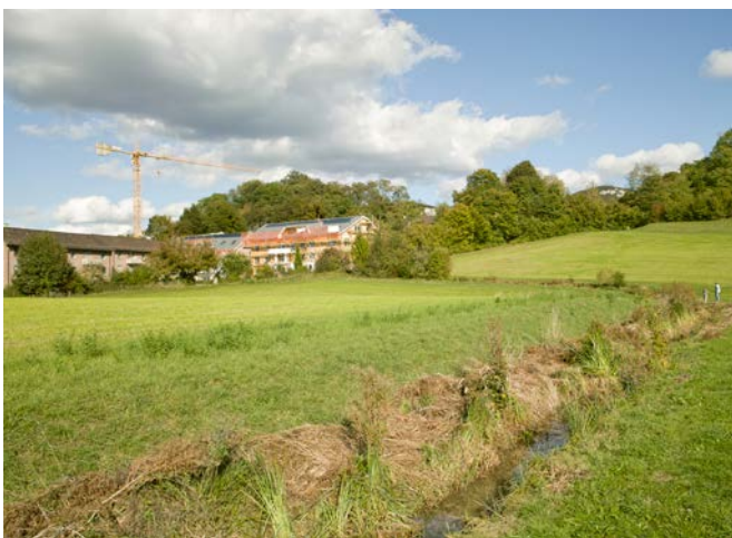
Zwischen Dornach und Aesch: Bauzone aufgefüllt.
