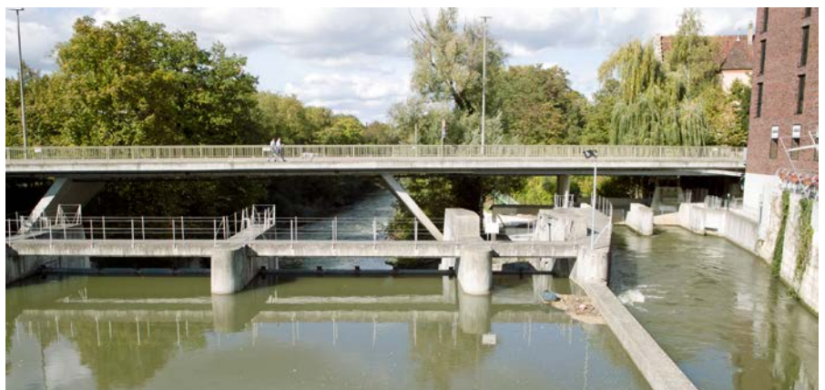
Dieses Kleinwasserkraftwerk in Dornach ist Teil der Birspark-Landschaft.
