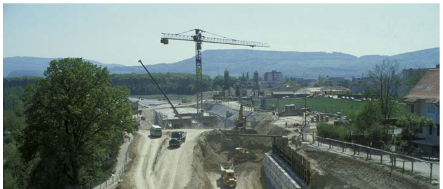
Dramatischer Eingriff in die Birslandschaft 1982: Bau der Schnellstrasse A18.
